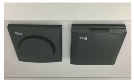
Detail umístění zásuvky a vypínače BERKER na spodní straně korpusu zrcadlových skříňek
