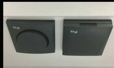
Detail umístění zásuvky a vypínače BERKER na spodní straně korpusu zrcadlových skříněk OMP ZS
