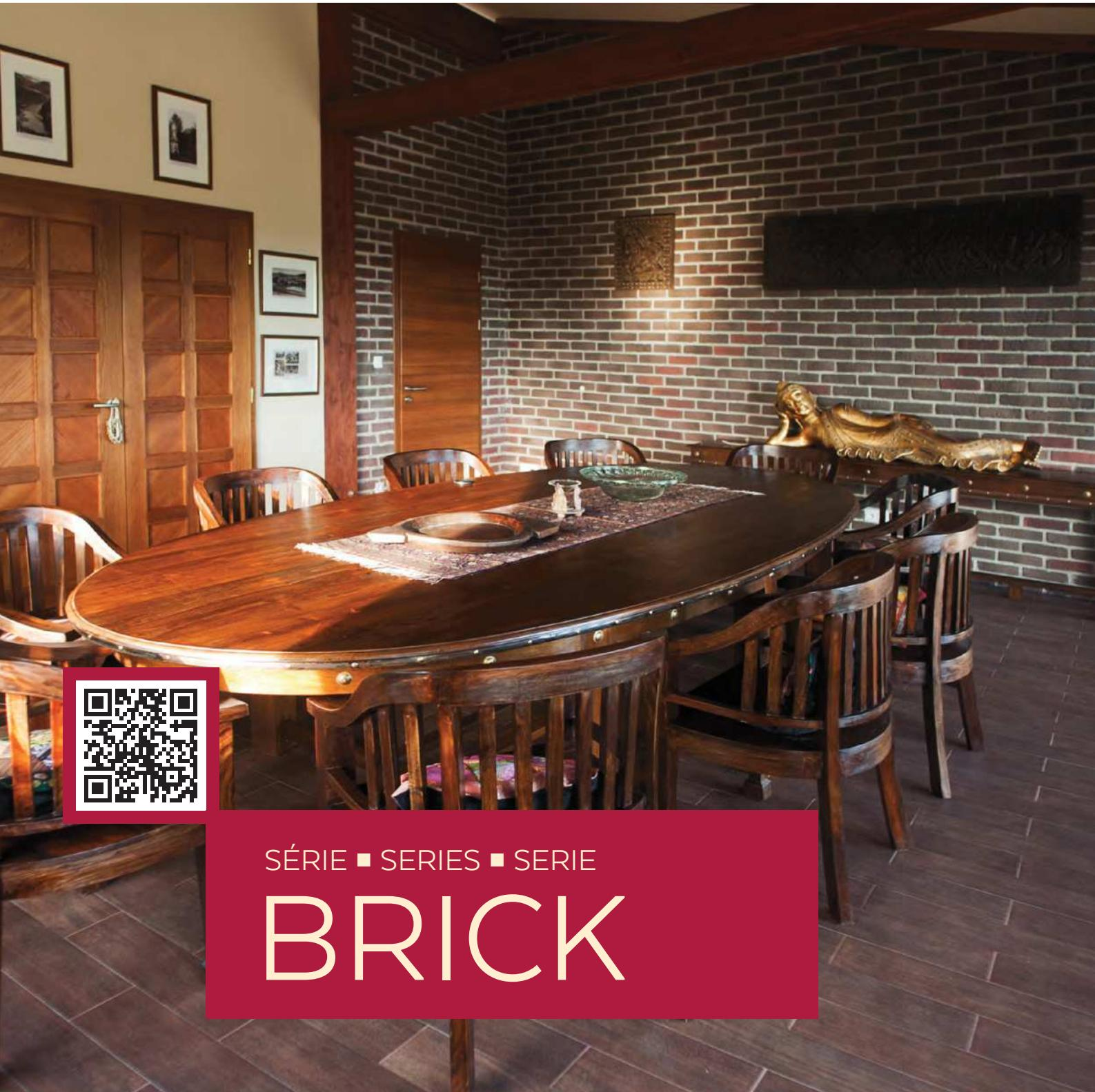
**Imitace režného zdiva použitím obkladových pásků. Jde o prvky z betonové směsi, které jsou k nerozeznání od pálených klinker pásů.**
