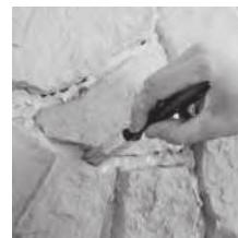
**CZ:** Poté spáru přehladte spárovacím žezezem.
